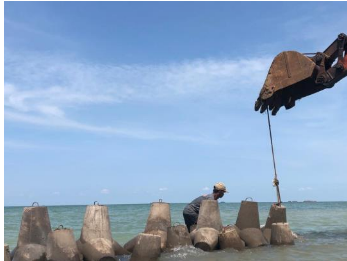
Gambar 6. Penempatan Breakwater Di Bibir Pantai
